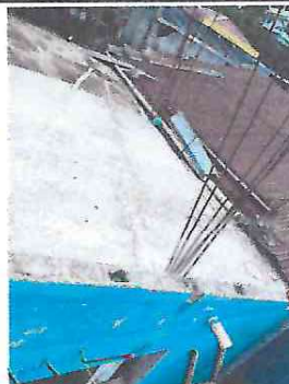
Foto 2: impermeabilizacion de loza
