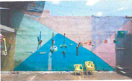
Foto 3: sustitucion de pintura
