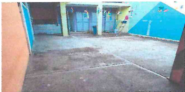
Foto 5: Reparacion de piso de torta de concreto
