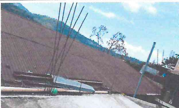
Foto 3: Sustituvion de tuvo pc 3"
