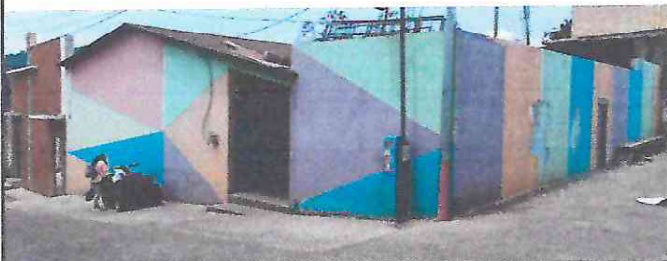
Foto1: Pintura de muro exterior
