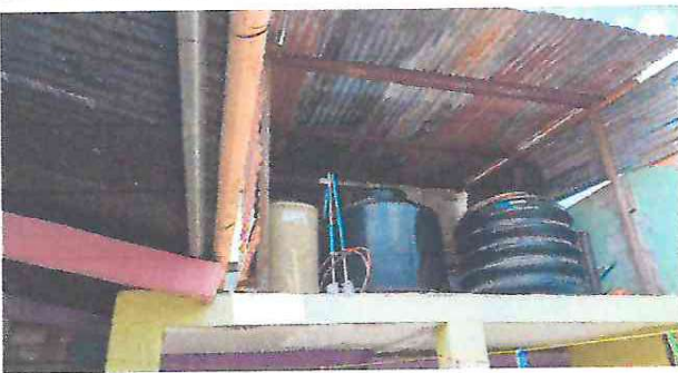
Foto 5: Sustitucion de depositos de agua y sustitucion de accesorios
